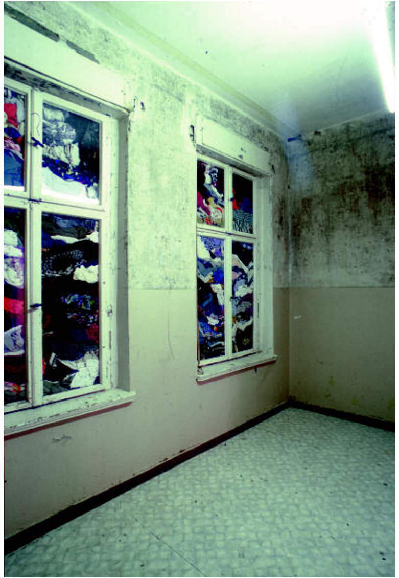
Kleidung gelegt zwischen Fensterscheiben Ubrania ułożone pomiędzy oknami
